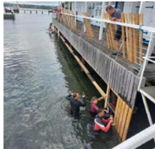
An der Unterkonstruktion wurden bis zu vier Meter lange Planken aus Eichenholz erneuert.
